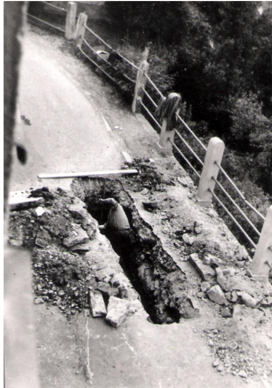
Kopanje kanalizacije, po 1980
