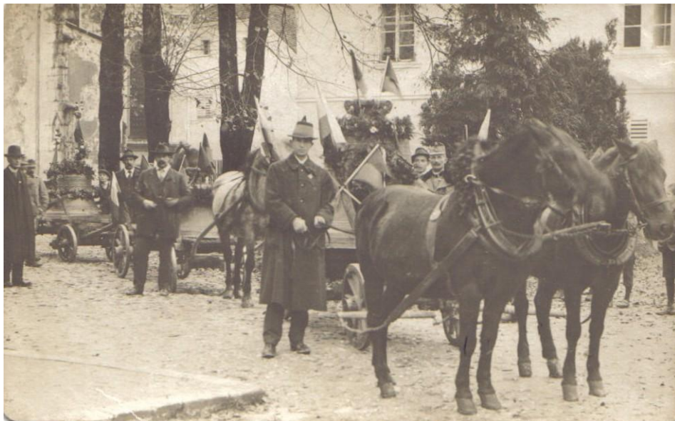
Odvzem zvonov v Radovljici, 1916
