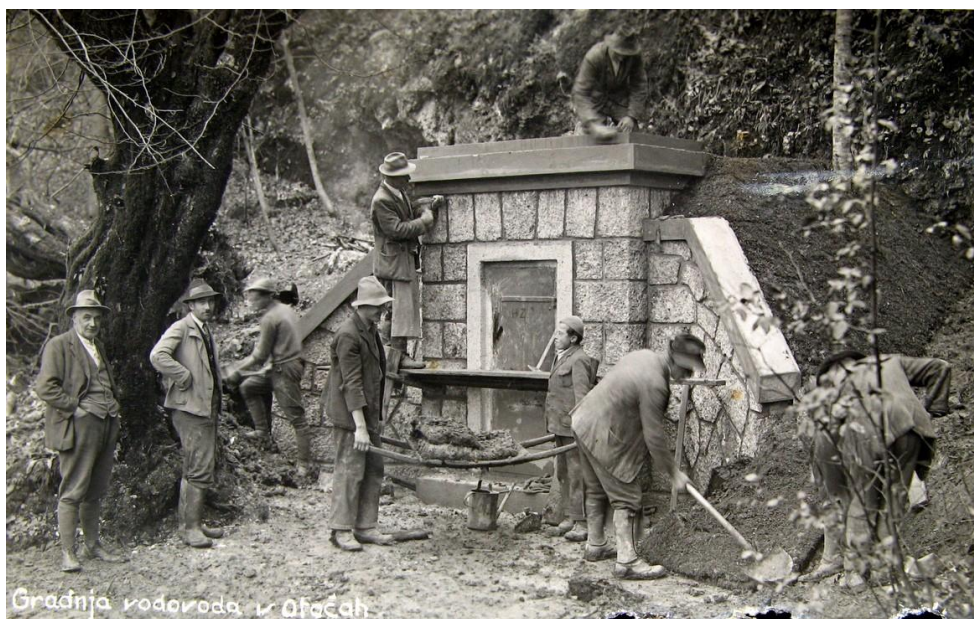
Gradnja vodovoda v Otočah, 1935 Vir: arhiv Rok Gašperšič
