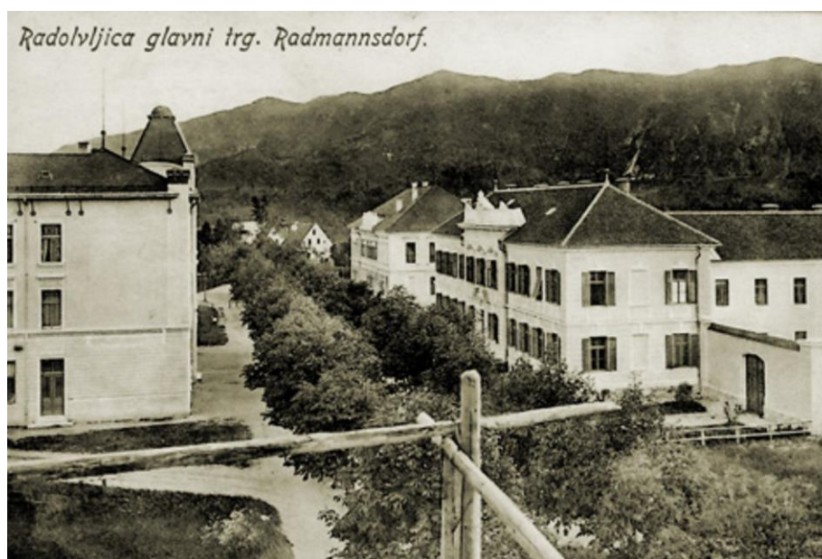
Stavba sodišča, 1914-17 Vir: spletna stran KS Radovljica
