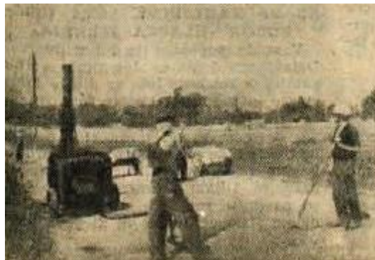
Asfaltiranje ceste v Hlebcah, 1957
