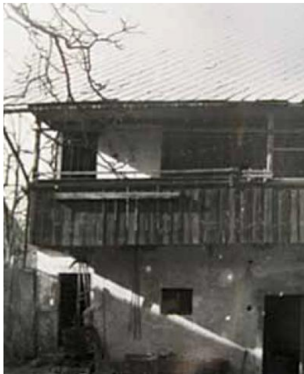
Blekovo dvorišče in gank, nekoč Vir: Mišače in Rodbina Pegam (avtor Rok Gašperšič)
