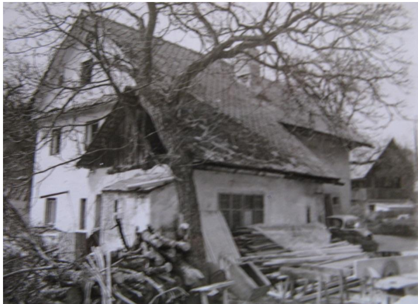
Prvotna Blekova hiša – porušeno 1989 Vir: Mišače in Rodbina Pegam (avtor Rok Gašperšič)
