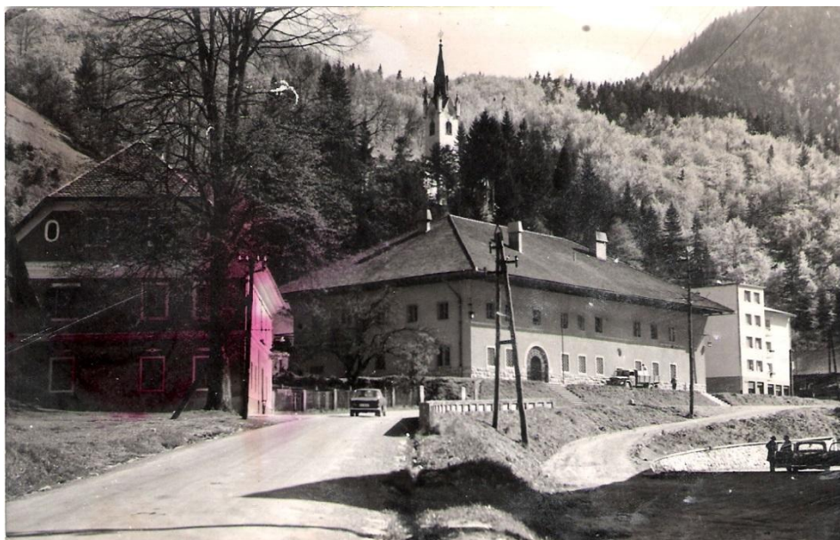
Cesta mimo Kulturnega doma, ok. 1960
