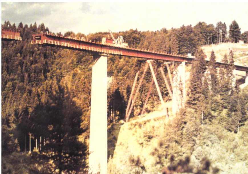
Gradnja viadukta Peračica, 1966 Vir: foto in arhiv Drago Papler
