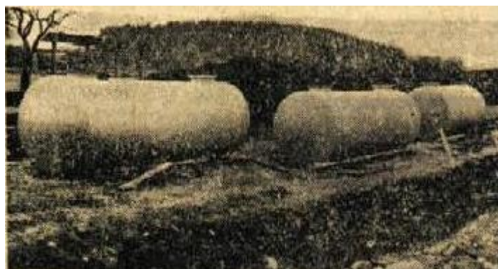
Radovljica – Cisterne za novo bencinsko črpalke ob cesti I. reda Kranj-Jesenice na odseku pri Radovljici so že pripravljene. Kmalu jih bodo zakopali v zemljo, potem pa bodo zgradili še poslopje za bencinsko črpalke. / Foto F. Perdan Vir: Glas, 11. 4. 1962
