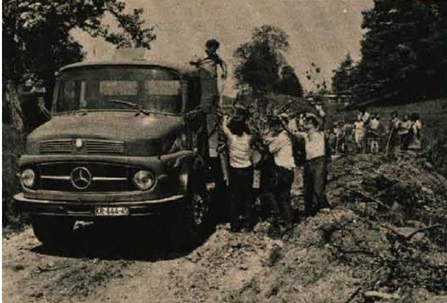
Prek 60 prebivalcev vasi Brda in Vošče v krajevni skupnosti Lancovo je v nedeljo sodelovalo v akciji pri gradnji ceste / Foto: A. Žalar
