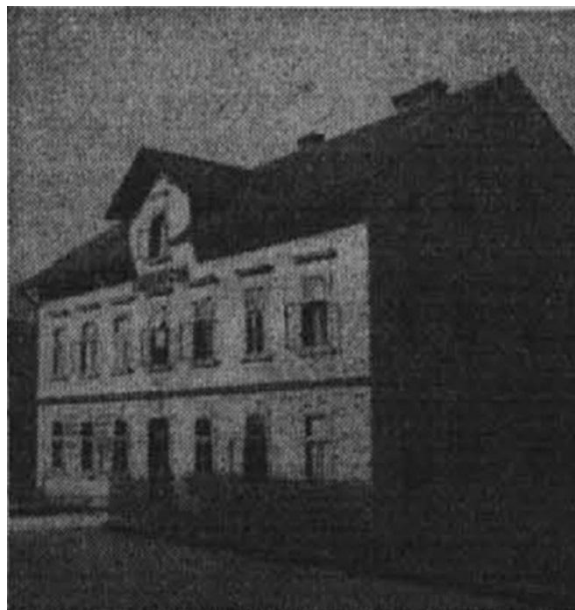
Stavba pred prezidavo, 1941
