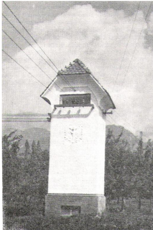
Podeželska transformatorska postaja Zapuže (KDE), zgrajeno 1915 Vir: Razvoj elektrifikacije Slovenije - Tretja etapa 1901-1909 (izdalo Elektrogospodarstvo Slovenije, 1976)
