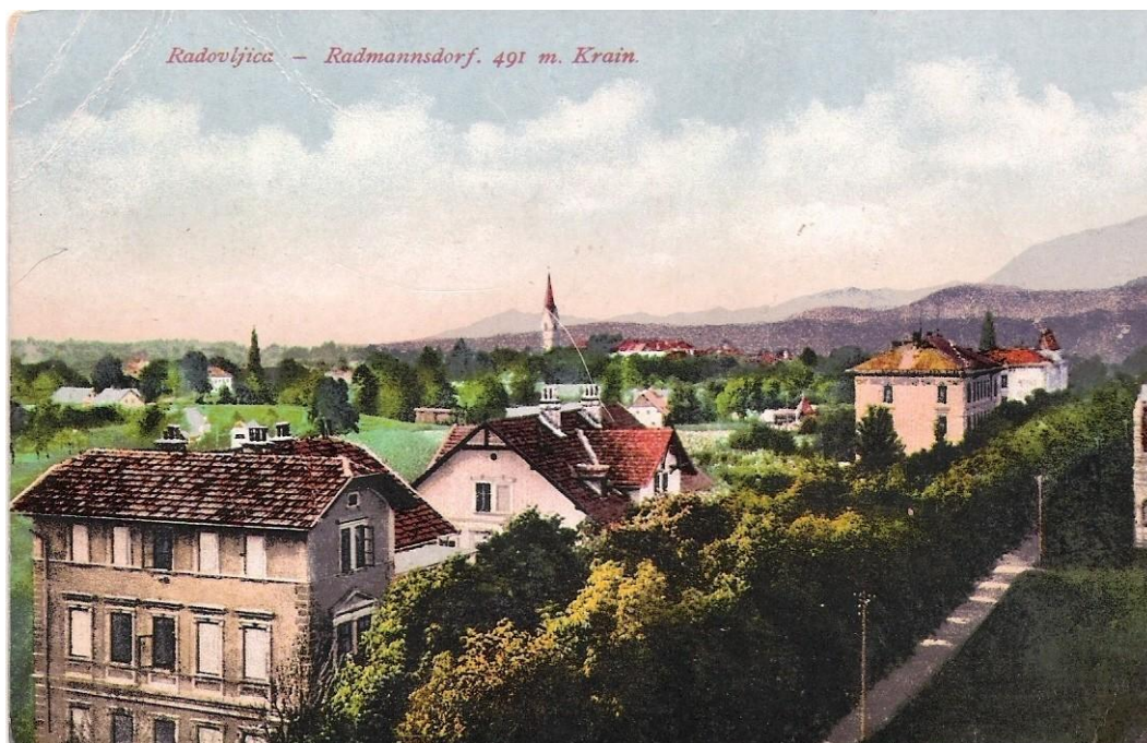
Prva razglednica Radovljice z drogovoma el. napeljave, ok. 1915 Vir: Digitalni arhiv Radovljica
