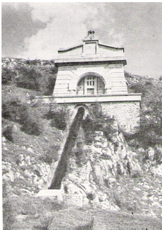
Vodostan v Mostah, zgrajen 1915 Vir: Jeseniški zbornik
